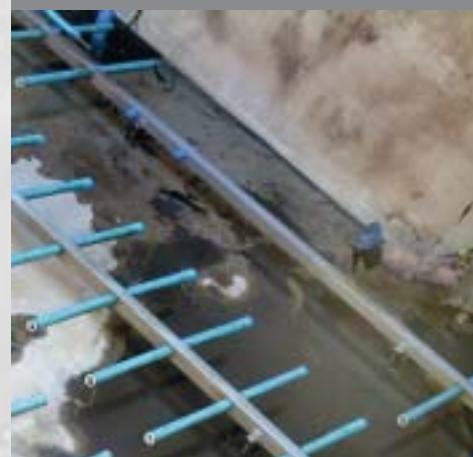
TR 50-2 в аэрационном резервуаре
